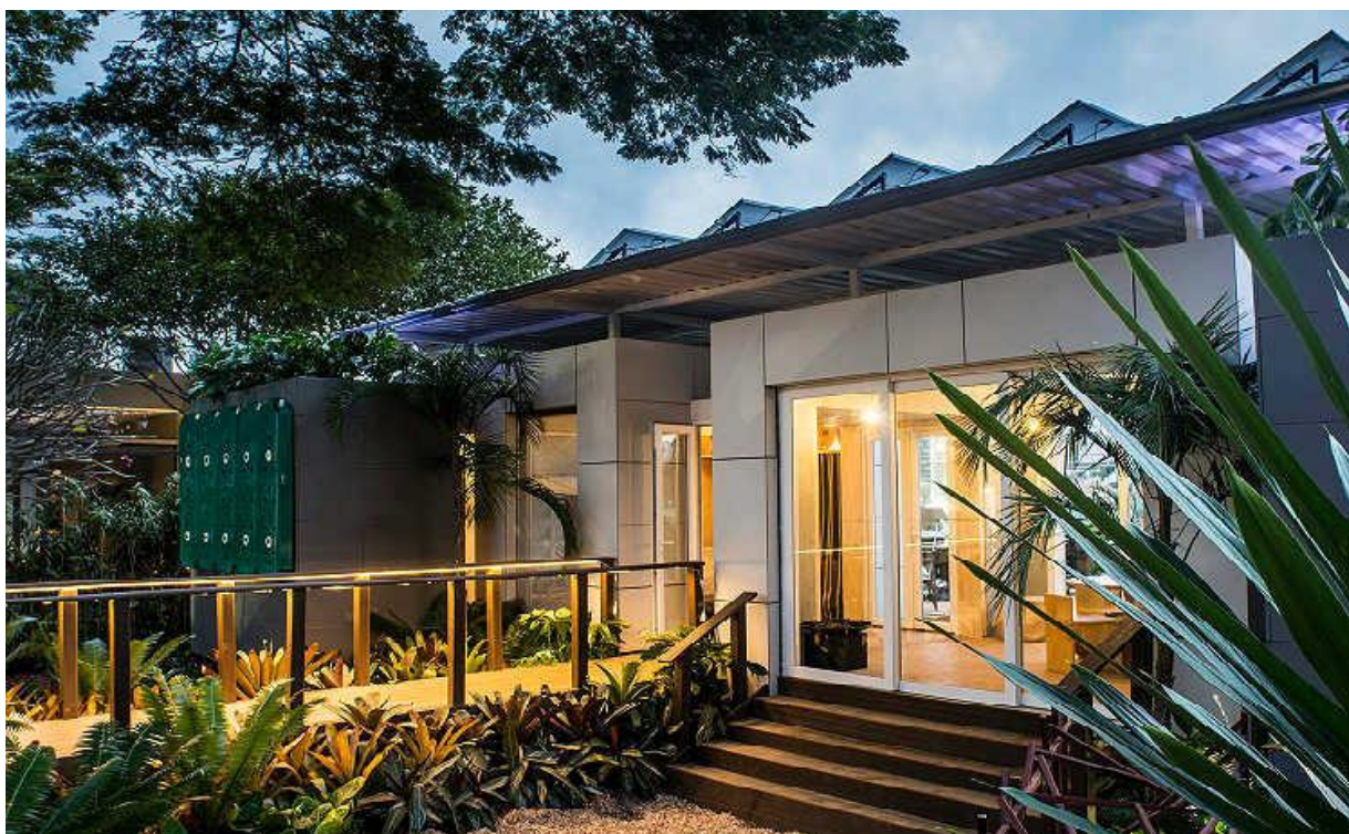
Figura 20 - Imagem da Fachada
