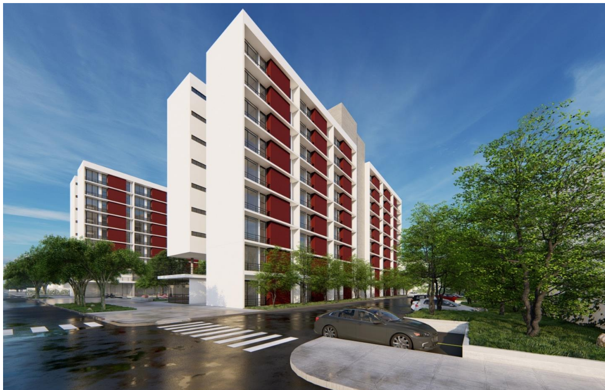
Figura 73 – Vista lateral da edificação
